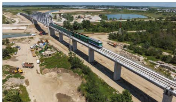
S.C. PORR CONSTRUCT S.R.L., București ⑥ Modernizarea liniei CF București Nord – Jilava – Giurgiu Nord – Giurgiu Nord Frontieră Lot 1: redeschiderea circulației feroviare pe pod peste râul Argeș, între Vidra și Comana
