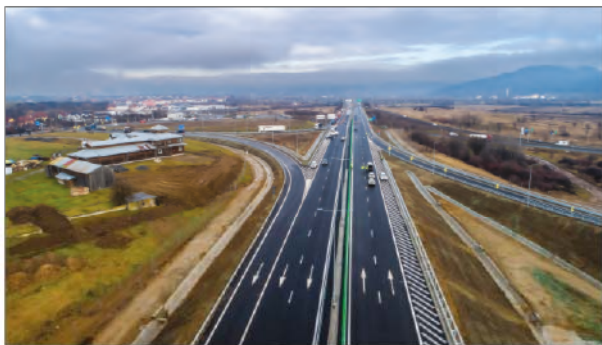
⑩ S.C. PORR CONSTRUCT S.R.L., București Proiectare și execuție autostrada Sibiu – Pitești Secțiunea 1 Sibiu – Boița Km0+000-Km14+500 Lot 1 Km0+000-Km 13+170
