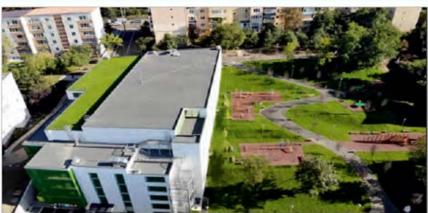
⑤ TCI CONTRACTOR GENERAL S.A., Cluj-Napoca Proiectare și execuție – parking Primăverii 20, Mun. Cluj-Napoca
