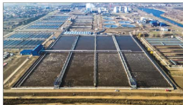
S.C. FCC CONSTRUCCION S.A., București ⑧ Extinderea stației de epurare a apelor uzate și construcția incineratorului de nămol
