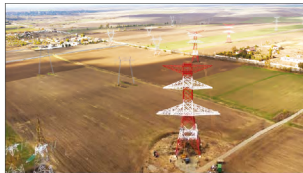
S.C. ELECTROMONTAJ S.A. ⑪ Linia electrică aeriană (LEA) 400 KV dublu circuit Cernavodă - Stâlp și racord în stația Gura Ialomiței
