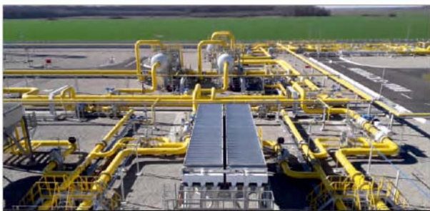
① S.C. INSPET S.A. Ploiești Lucrări de execuție pentru stațiile de comprimare gaze naturale din cadrul Proiectului Brua – faza 1
