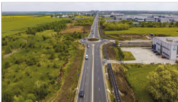
⑨ S.C. STRABAG S.R.L., București Modernizare DJ 691: lărgirea la 4 benzi a sectorului Km2+725 (sens giratoriu) – centura Timișoara și centura Timișoara – Autostrada A1 (Km12+975) LOTUL2 Km5+800-Km12+975
