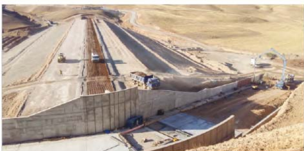
⑨ S.C. HIDROCONSTRUCȚIA S.A., București Baraj Chamrga - Iraq - Regiunea Kurdistan
