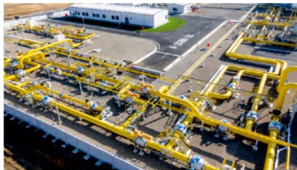
S.C. INSPET S.A., Ploiești ⑦ Execuția stației de comprimare gaze naturale Onești-M
