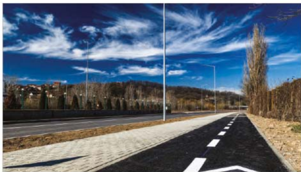
⑤ S.C. STRABAG S.R.L., București Legătură rutieră între artera principală a Reșiței și Parcul Industrial și zona de regenerare urbană Mociur, în vederea extinderii transportului în comun – Faza 1 + Faza 2
